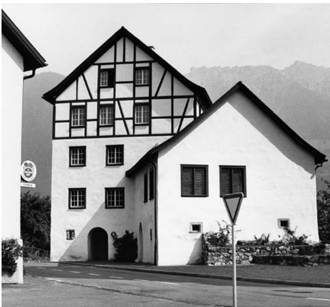
Fotos der Pfrundbauten nach der Renovierung, Zustand 1976. Eine letzte Fassadensanierung erfolgte 1994.
